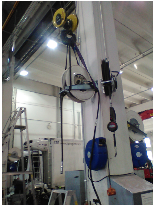
Kuva 1.3: Ihan ei päässyt raanalla seinän viereen, vaan piti heilautella painavaa jöötiä samalla toivoen kiinnitysreikien osumista pultteihin. Nopea sai myös olla, koska tuota ei jaksanut pitää kauaa ääriasennossa mutterin kiristystä varten.
